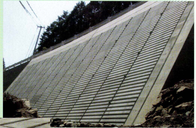
完成！道路下壁高8m (勾配0.4)
