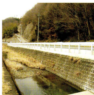
既設ブロック積擁壁
