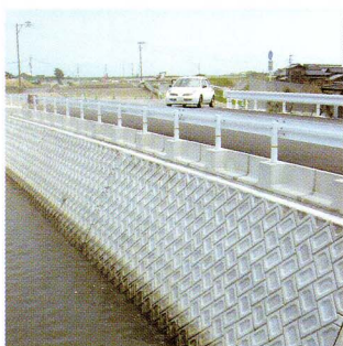
ブロック積擁壁
