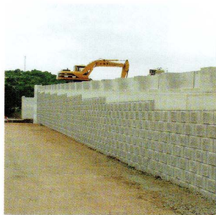
補強土壁 (ジオグリッド)
