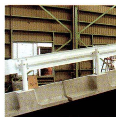
縦断16%の設置確認
