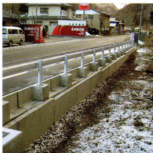
L型擁壁 (天端部分を外した例)
