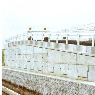
補強土壁 (テールアルメ)
