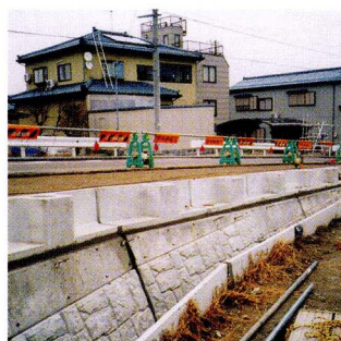
大型ブロック積擁壁
