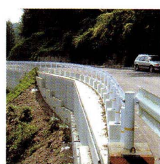
EPS上への設置
